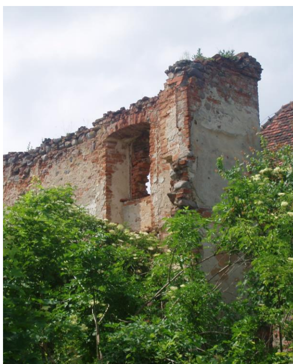
Fot. Ruiny Pałacu w Szcząncu
